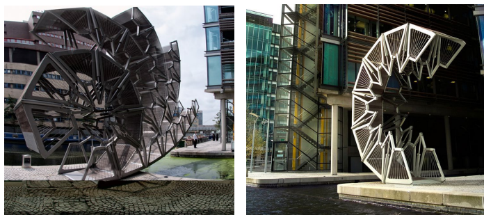
Рис. 4. Мост-восьмиугольник Rolling Bridge, Лондон, Англия (Источник: https://www.architime.ru/specarch/thomas_heatherwick/rolling_brige.htm#11.jpg )
